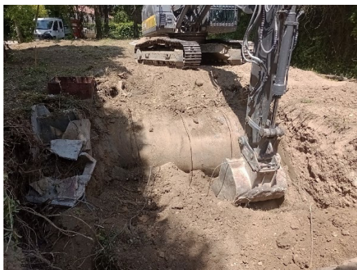
Fig. 3.2 -Asportazione terreni limitrofi alla cisterna
